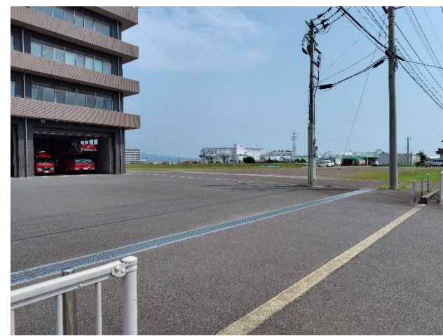
② 南側出入口
